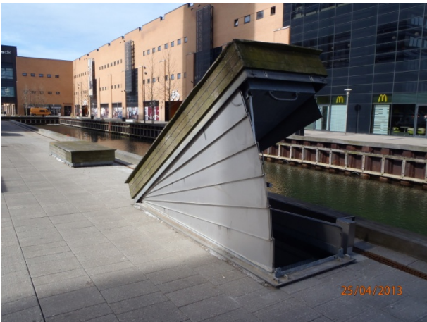
Figur 2 Eksempel på nedgangsdæksler udformet som byinventar
