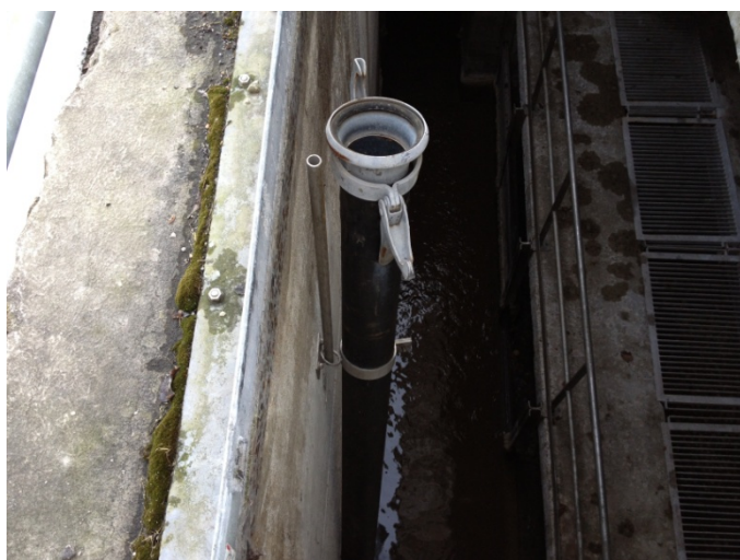
Figur 1 Slamsugerør til sump på større pumpestation
